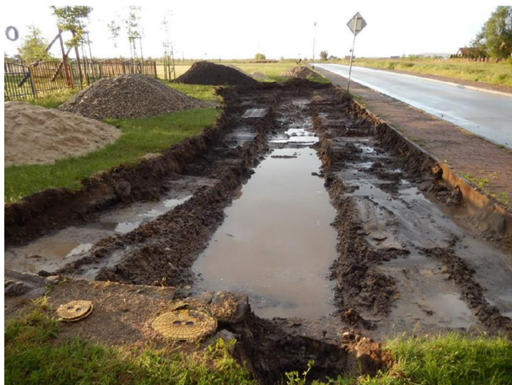
Fotografia 4. W trakcie realizacji ogrodu deszczowego
